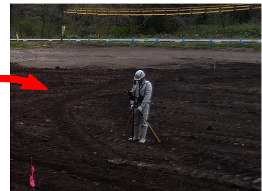
トータルステーションによる検測状況
