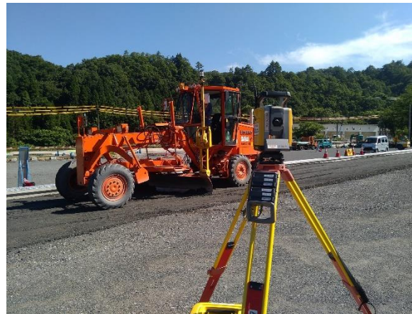
上層路盤施工状況 (MCモーターグレーダー)
