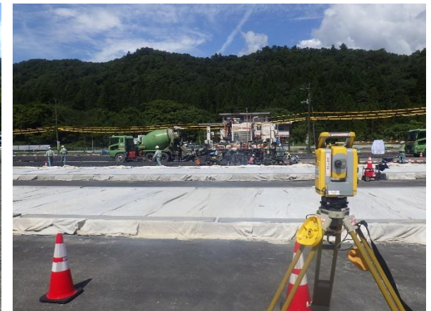
コンクリート舗装施工状況 (MCスリップフォームペーパー)
