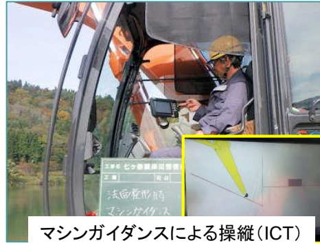
マシンガイダンスによる法面整形 (ICT)
