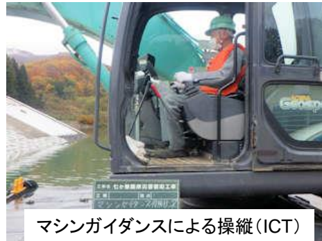
マシンガイダンスによる操縦 (ICT)
