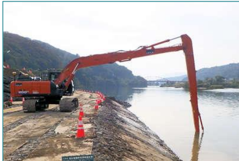
マシンガイダンスによる法面整形 (ICT)
