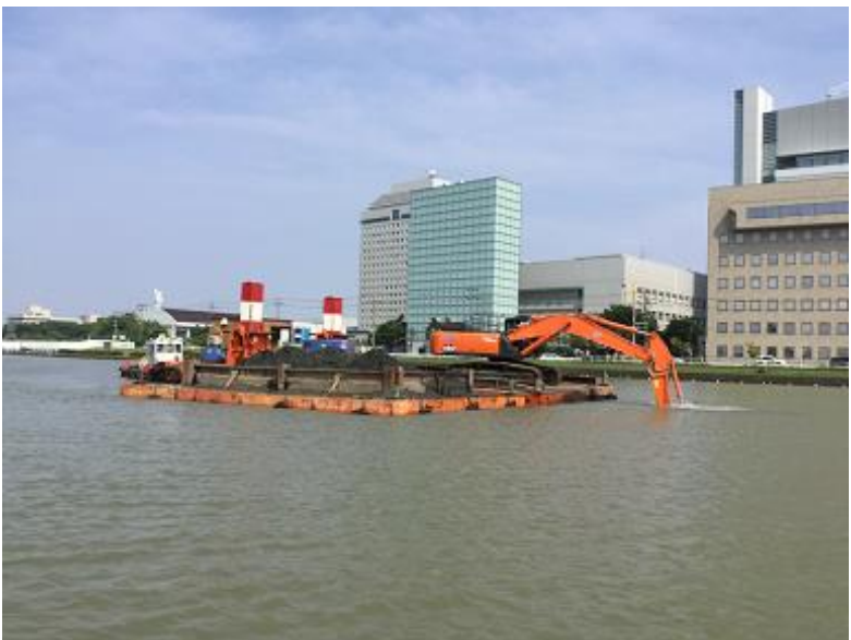
バックホウ浚渫状況
