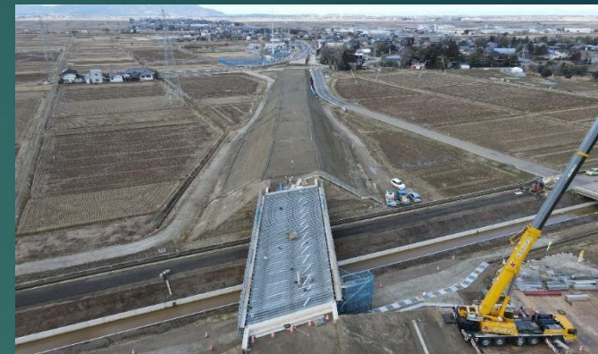
サーチャージ盛土工 竣工
