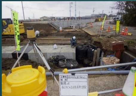
自動追尾式TSによるワンマン測量
