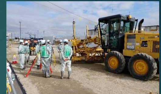
現場教育（ICT舗装工）
