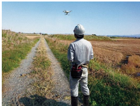
3次元起工測量
