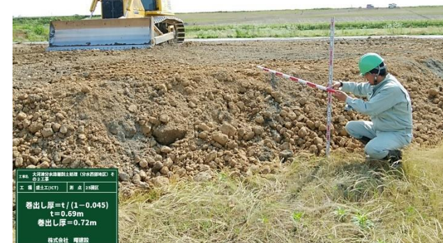
敷均し厚さ確認
