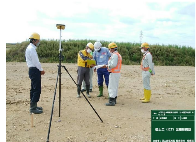
盛土工出来形確認
