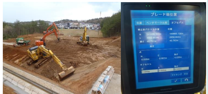
③ ICT建設機械による施工(掘削、バケットオフセット)
