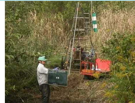
調査ボーリング
