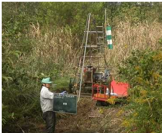
調査ボーリング
