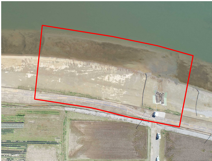
河道掘削完了
