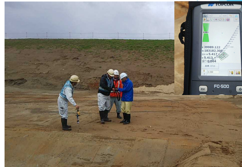
GNSSローバーによる出来形確認
