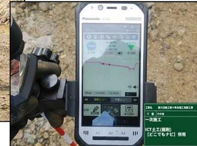
参考資料⑤ 3D設計データによる掘削中の現況確認
