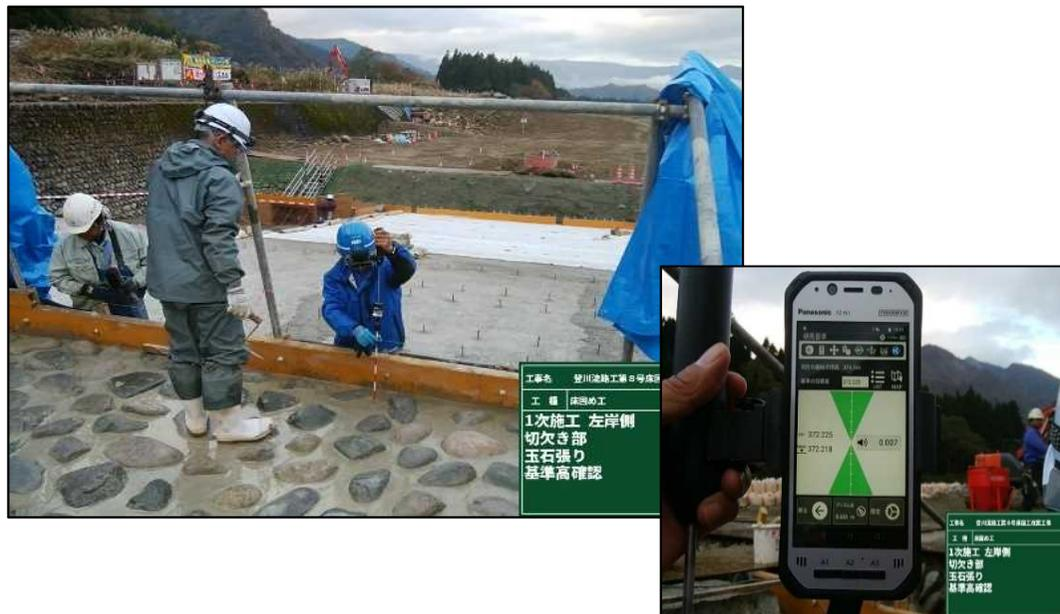
参考資料⑥ コンクリート構造物用3D設計データによる現況確認
