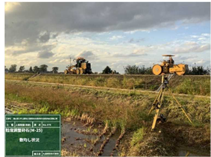
ICTでの施工状況
