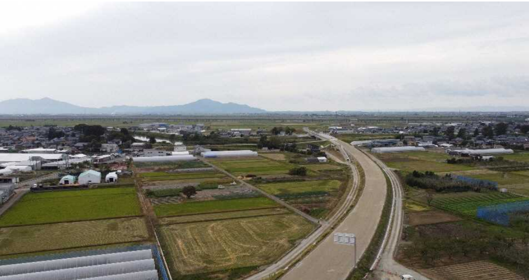
ICT施工で施工した上層路盤(完了写真)
