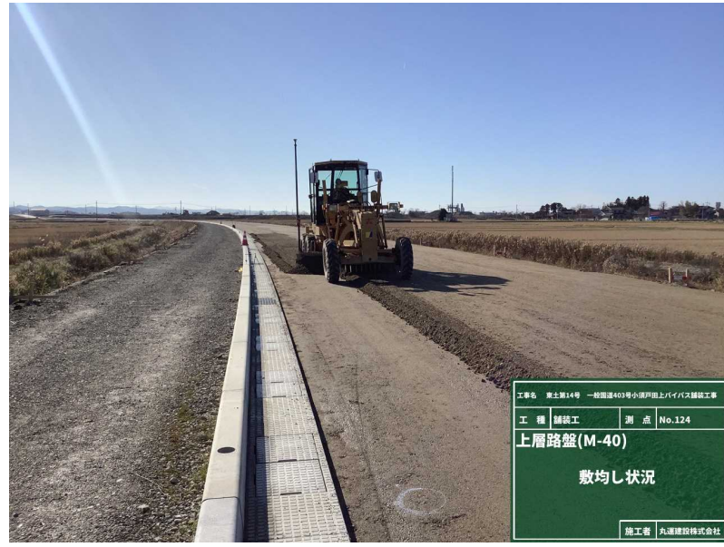
ICT施工状況
