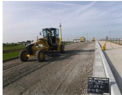
ICT舗装工（下層路盤工）施工状況
