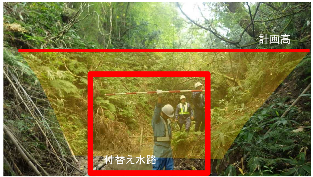
狭隘部(1号トンネル、2号トンネル間)の現地写真
