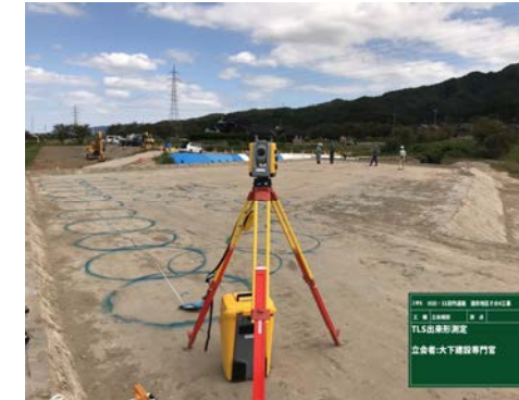
TSによる出来形臨場確認
