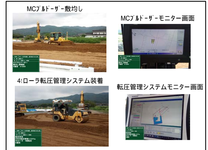
ICT施工状況
