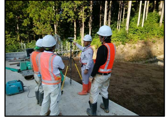
写真11: 施工手順説明 (現場)
