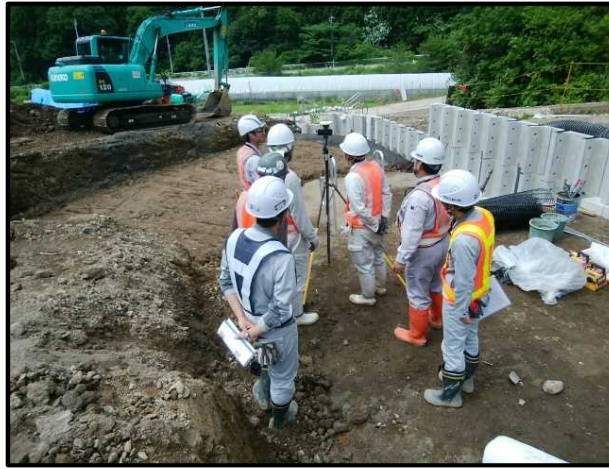
写真10: 施工手順説明 (現場)
