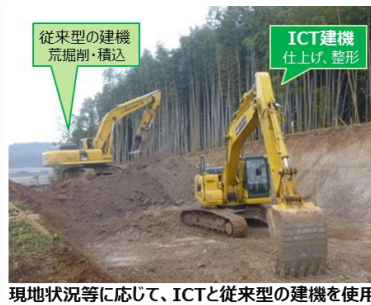
現地状況等に応じて、ICTと従来型の建機を使用
