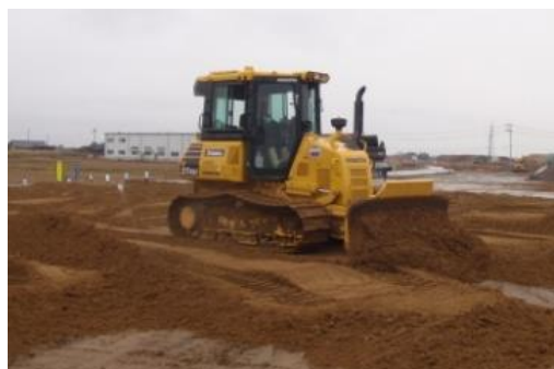
自動制御による押土作業状況
