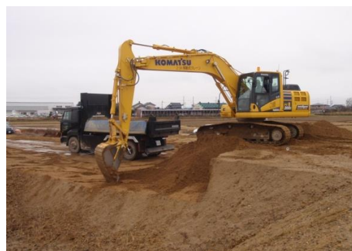
自動アシストによる設計面付近の掘削状況
