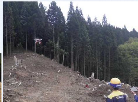
UAVにより速やかな3次元点群データの取得が可能
