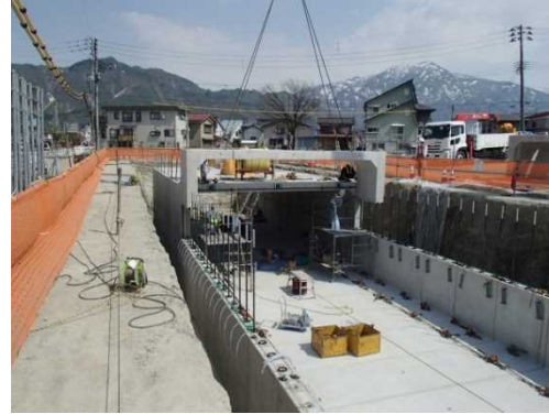
国道17号 六日町バイパス(H27施工)
