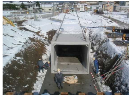
国道8号 糸魚川東バイパス(H19施工)
