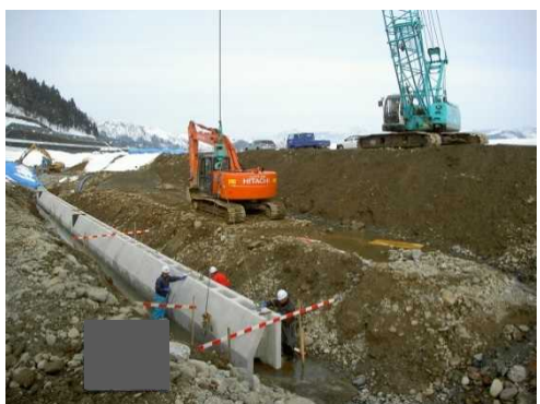
魚野川 浦佐(H23施工)
