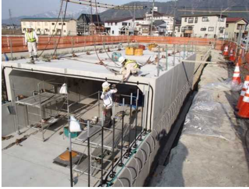
国道17号 六日町バイパス(H27施工)
