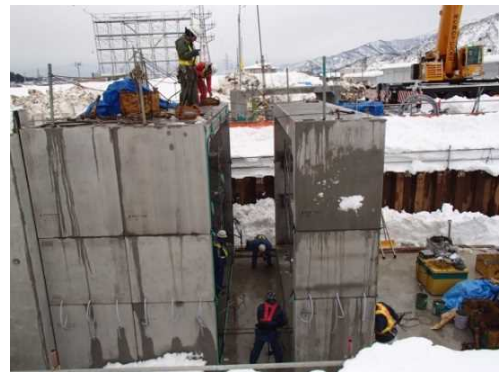
国道17号 六日町バイパス(H26施工)
