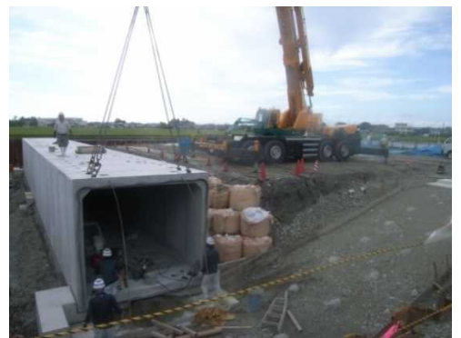
国道359号 砺波東バイパス(H26施工)
