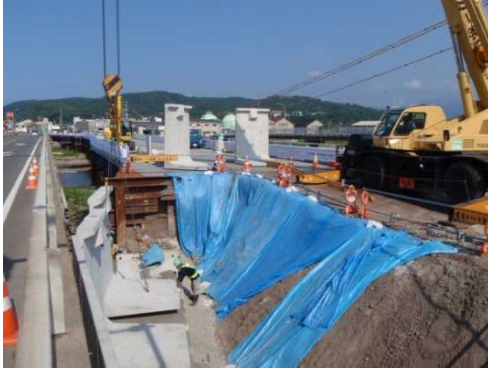
国道8号 能生大橋架替(H21施工)
