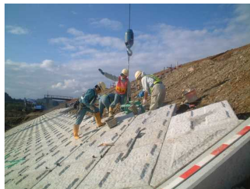
魚野川 新道島(H17施工)
