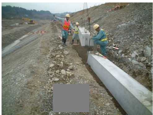
魚野川 新道島(H17施工)
