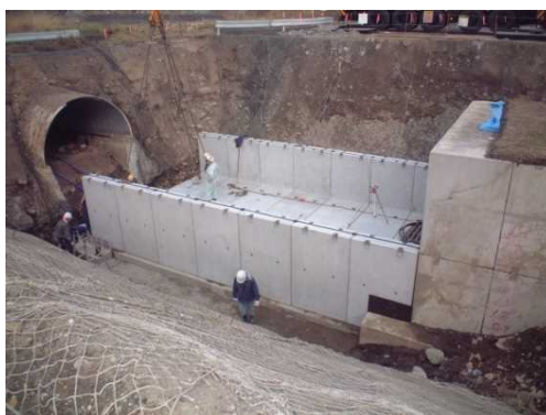
国道8号 糸魚川東バイパス(H18施工)
