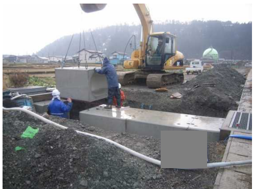
国道8号 糸魚川東バイパス(H19施工)
