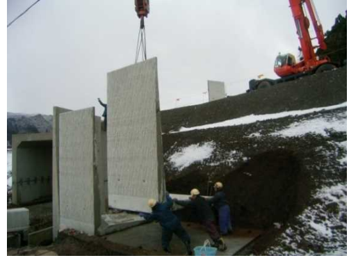
国道8号 糸魚川東バイパス(H19施工)
