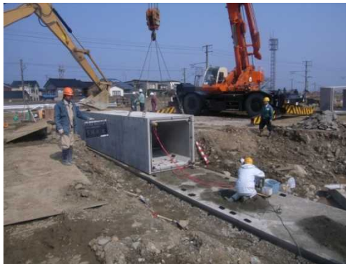
国道8号 糸魚川東バイパス(H19施工)
