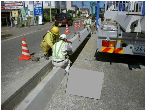
国道17号 魚沼市(H25施工)
