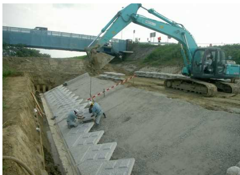
信濃川 本与板(H23施工)
