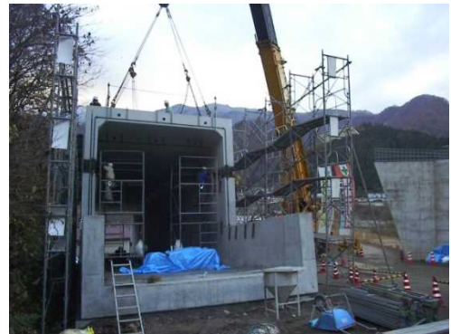
国道148号 小谷道路(H17施工)
