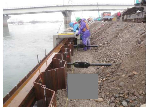
信濃川 信濃 (H25施工)
