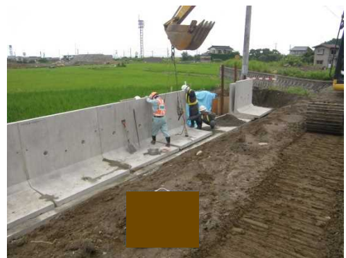
国道8号 糸魚川東バイパス(H21施工)
