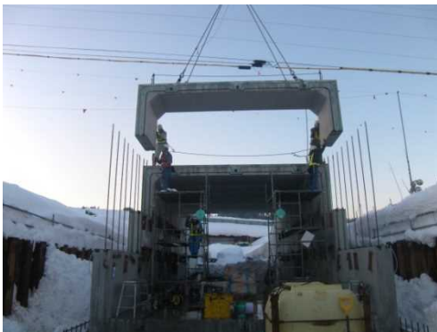
国道17号 六日町バイパス(H26施工)
