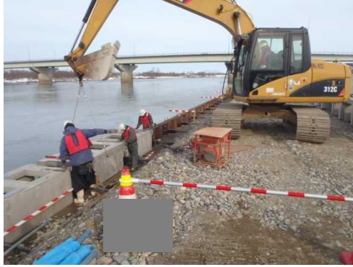
信濃川 信濃 (H25施工)
