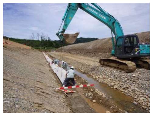
魚野川 下島 (H25施工)
