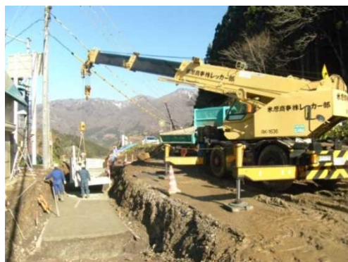
国道148号 小谷道路(H22施工)
