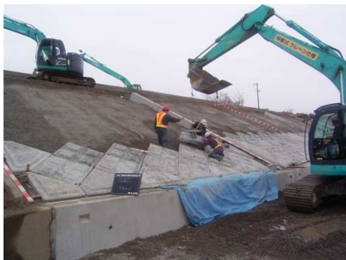
信濃川 蓮湯(H20施工)
