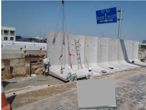
国道8号 坂東交差点立体化(H27施工)
