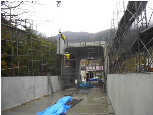
国道148号 小谷道路(H17施工)
