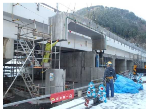
国道8号 歌高架橋架替(H25施工)
