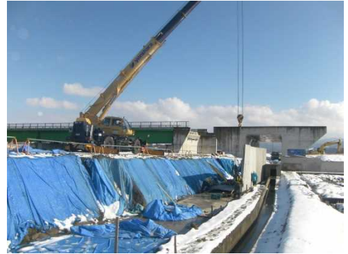
国道8号 入善黒部バイパス(H25施工)
