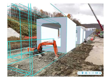
掘削作業時にARと比較
