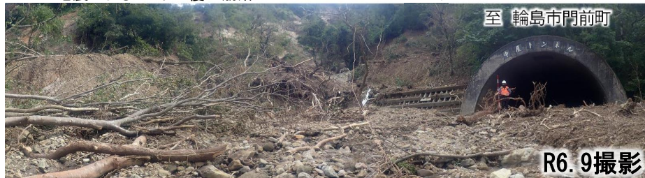
大雨による中屋トンネル輪島市街地側坑口閉塞状況
