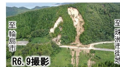
大雨による斜面崩落
