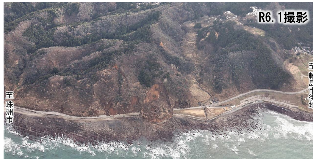
地震による道路決壊を伴う地すべり
