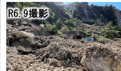
大雨による地すべり・斜面崩落
