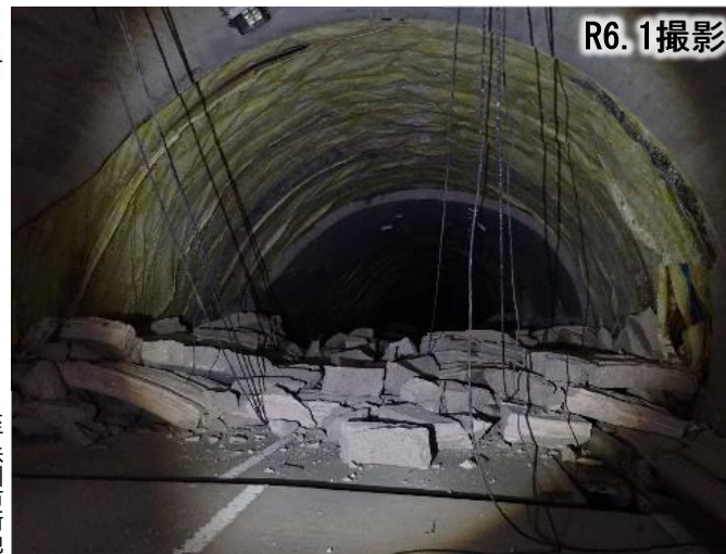
地震によるトンネル覆工崩落
