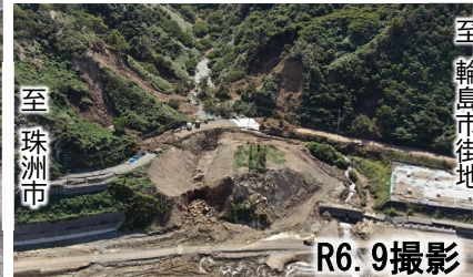
大雨による地すべり
