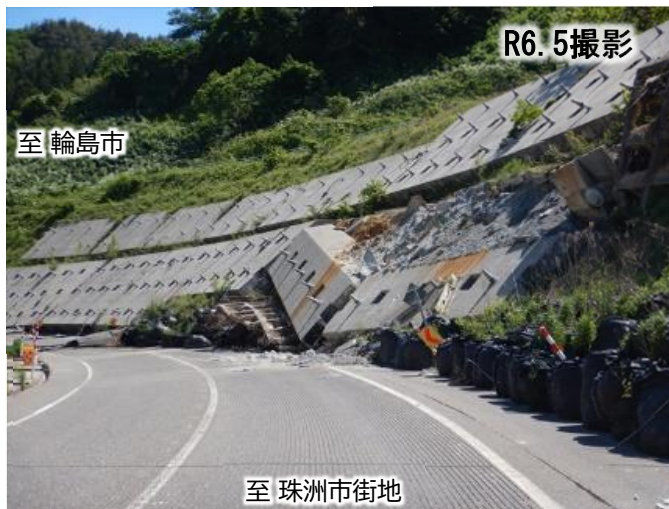
地震による法枠工崩壊
