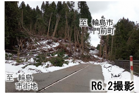
地震による斜面崩落
