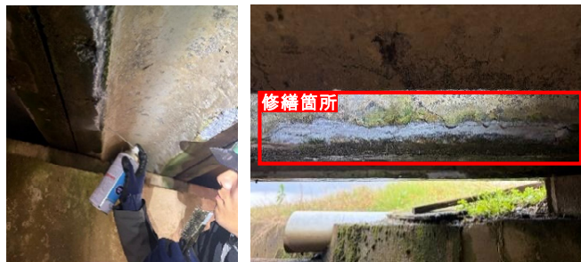
写真2 簡易補修の様子
