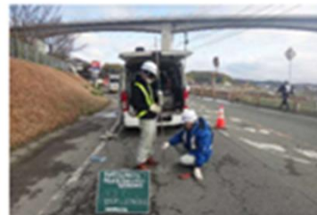
地上からの簡易貫入試験
