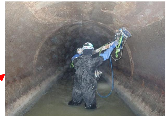
【今回】新潟県流域下水道 管路内からの地盤空洞調査の様子 11
