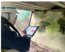
写真1 タブレット点検の様子
