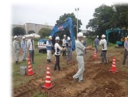
出来形計測実習
