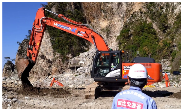
遠隔操縦により稼働する無人バックホウ
