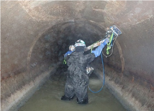
【今回】新潟県流域下水道（長岡処理区） 管路内からの地盤空洞調査の様子
