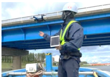
ドローンによる橋梁点検
