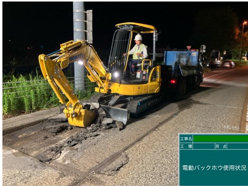
電動バックホウ作業状況 (舗装版撤去工)
