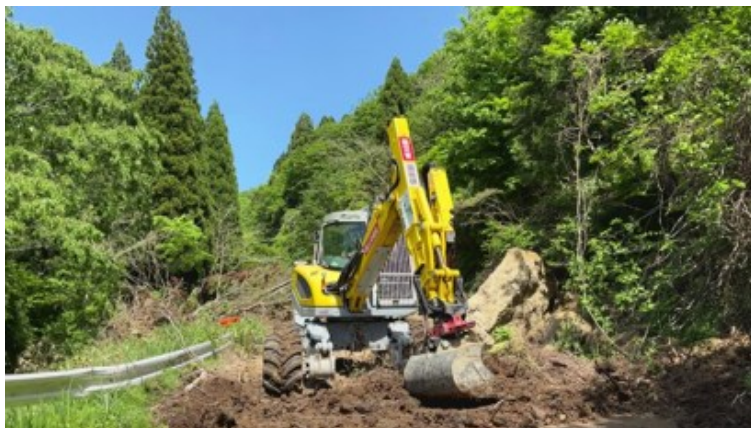
バケットによる掘削作業
