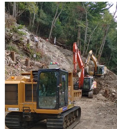
無人BH(遠隔操縦)による急峻な斜面中腹部での崩土撤去作業
