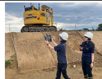
専門研修(LiDARによる出来形計測)
