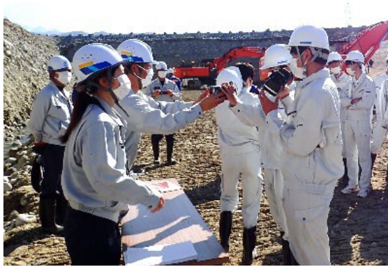
【VR(仮想現実)による工事施工体験】
