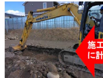
②3D-MG施工 + ②刃先による計測
