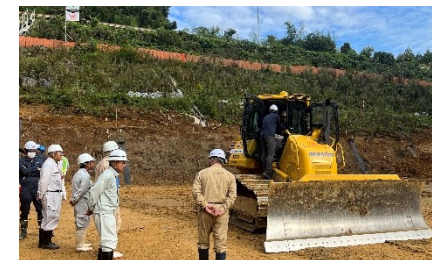
現場研修(ICT施工の実演状況)
