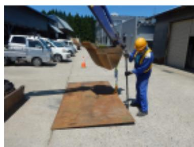
② 吊り金具を外すためのボールを鉄板に挟む
