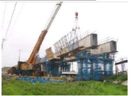
事例-2 安全仮設備等の工夫(足場の大組設置用の専用つり金具を製作)
