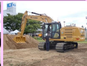
ICT遠隔施工講習会【新潟】
