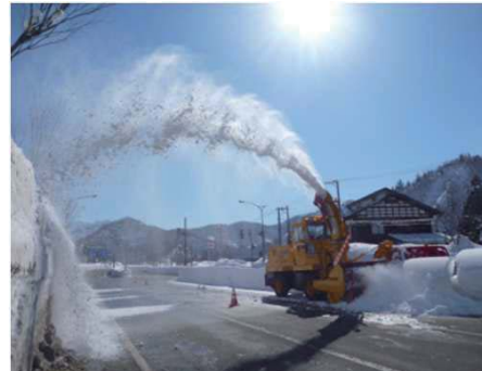
スイングオーガを活用した中分の雪堤処理
