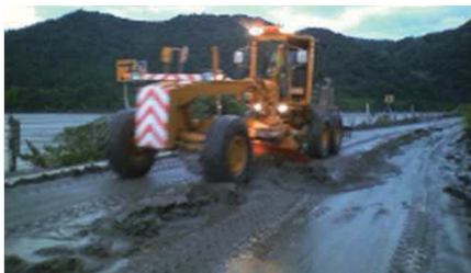
阿賀町大牧地区の道路決壊陥没箇所 (24時間施工により3日で片側通行に移行)
