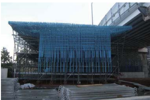
【鉄筋組立完了】
