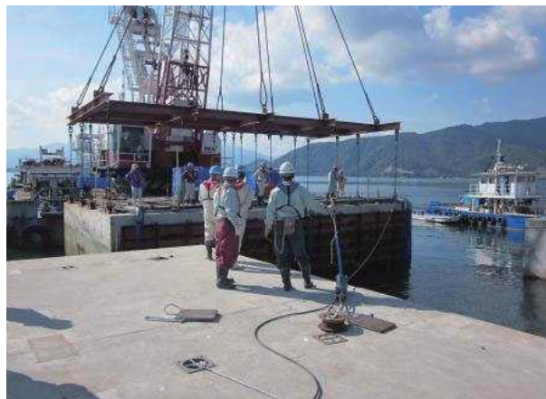
ケーソン再据付状況
