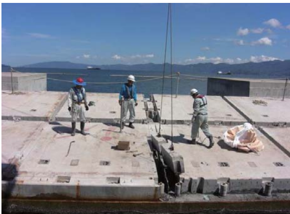
上床版撤去状況
