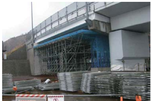
【引き込み完了】
