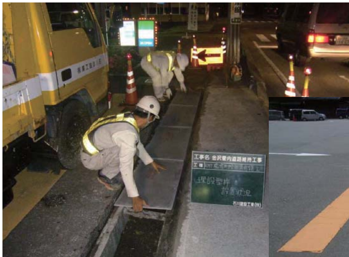
GRC製板埋設型枠を利用した側溝蓋補修工 (R159 金沢市)
