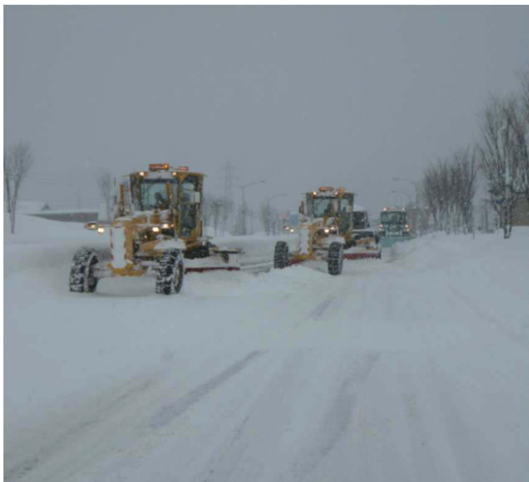
除雪作業状況
