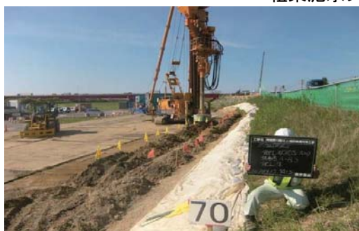
砂杭施工本数確認工夫
