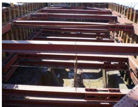
鋼矢板締切全景
