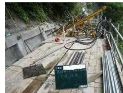
ケーシング併用による削孔
