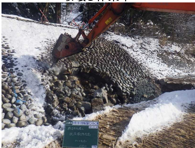
取壊し作業中
