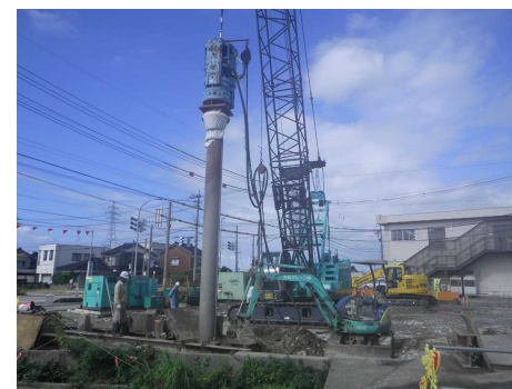
ダウンザホールハンマ施工状況
