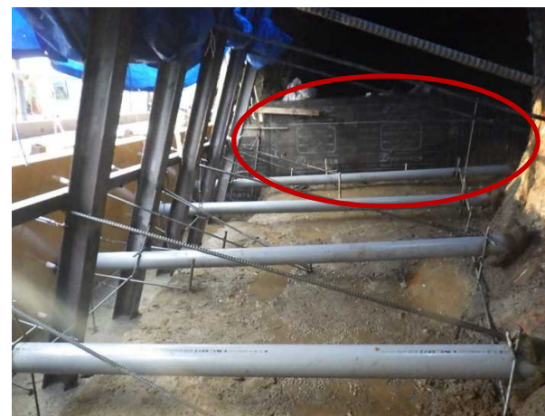
目地材設置状況
