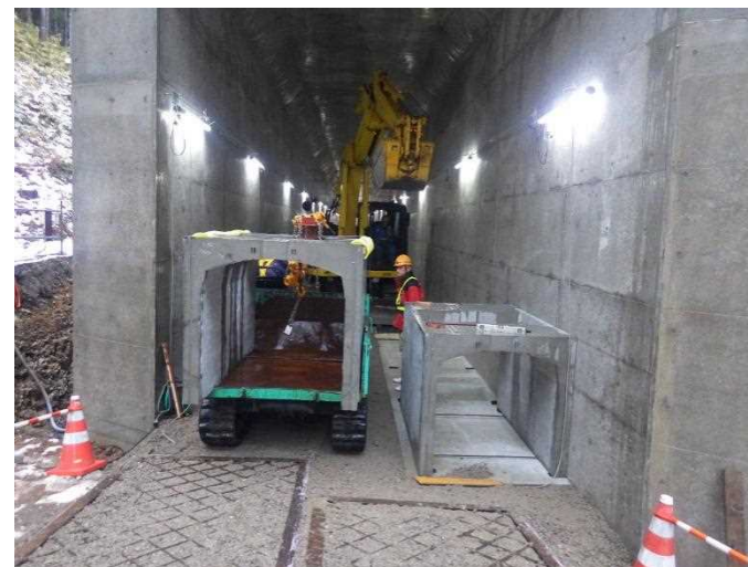
製品運搬据付状況
