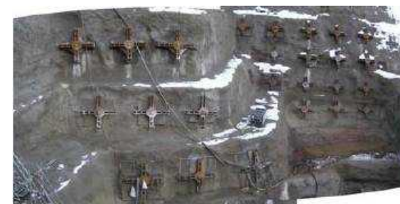
グラウンドアンカー施工状況
