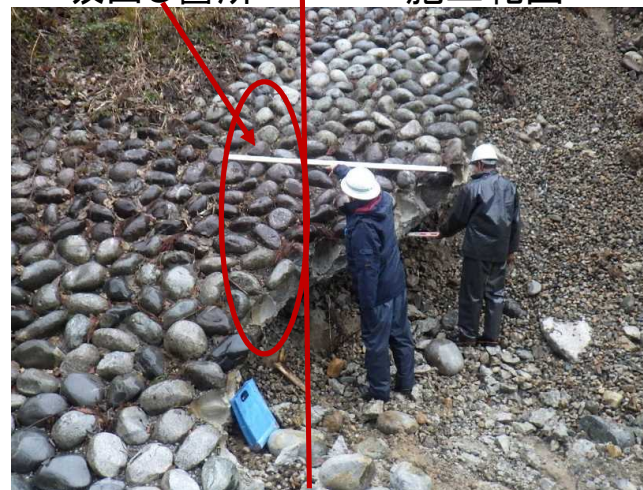
吸出し箇所 ← 施工範囲 →
