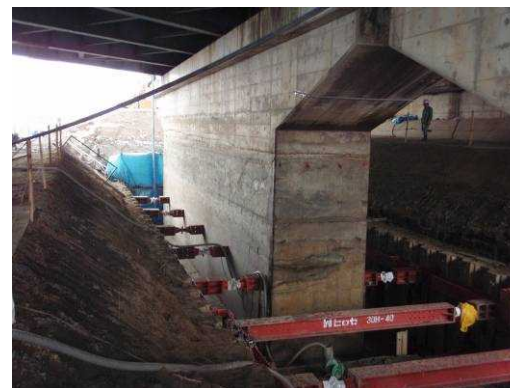
変更後の鋼矢板土留工
