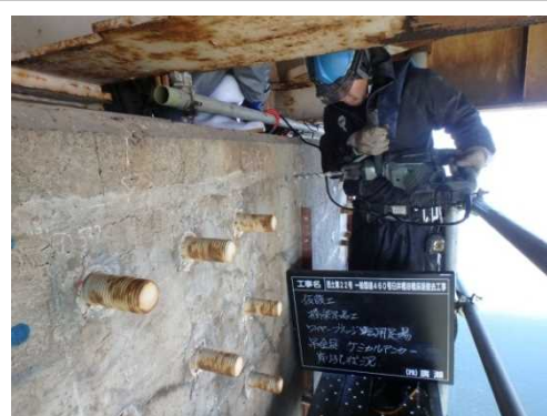
ブラケット足場設置後作業状況
