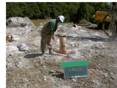
火薬充填状況
