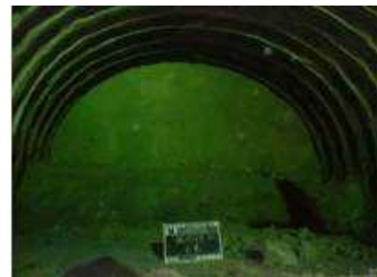
鏡吹付け施工完了状況
