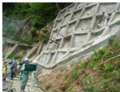
試験施工 削孔状況確認
