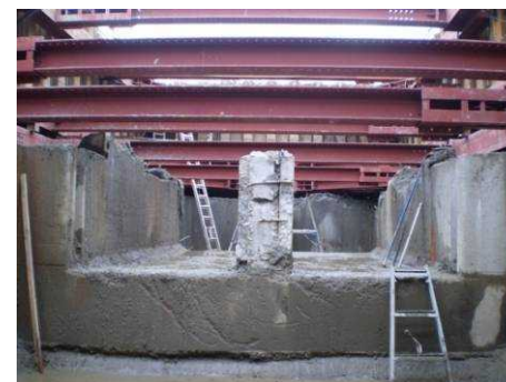
変更対象(切梁下方部)
