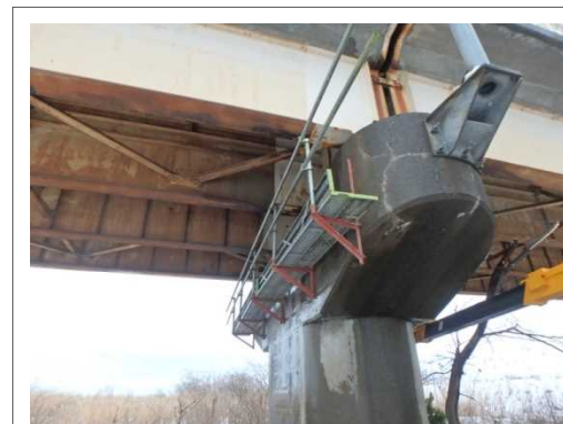
ブラケット足場設置後状況
