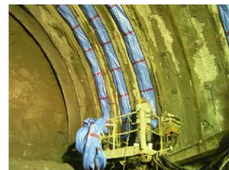
湧水処理施工状況
