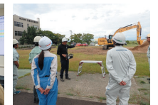
ICT遠隔施工講習会 (屋外実習フィールド)
