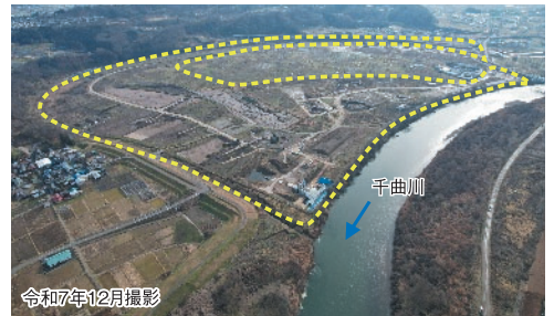
今井遊水地整備状況(長野県中野市)
