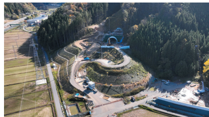
日本海沿岸東北自動車道 朝日温海道路(新潟県上市)
