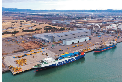
金沢港での建設機械の輸出の様子
