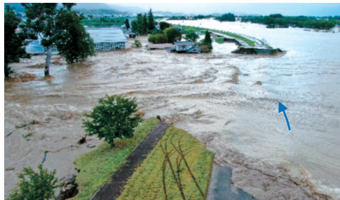
令和元年東日本台風による堤防決壊(長野県長野市)
