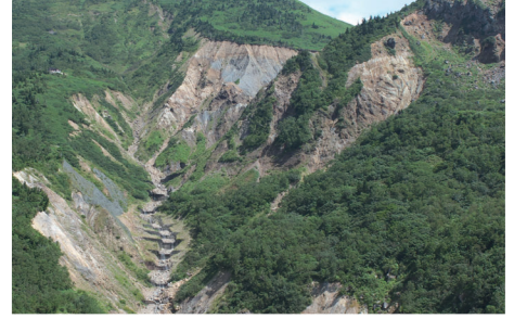
荒廃の著しい白山から下流域を守り続ける甚之助谷砂防堰堤群 (石川県白山市)
