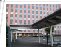
駐車場 雨除けの庇
