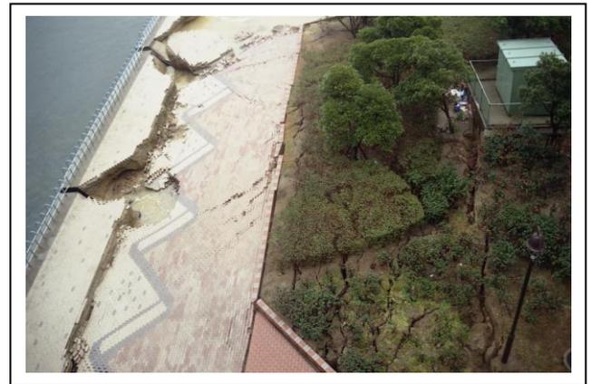
④側方流動による護岸の変状
