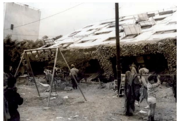
図-3.3 基礎部が現れた県営アパート(新潟市中央区川岸町)
