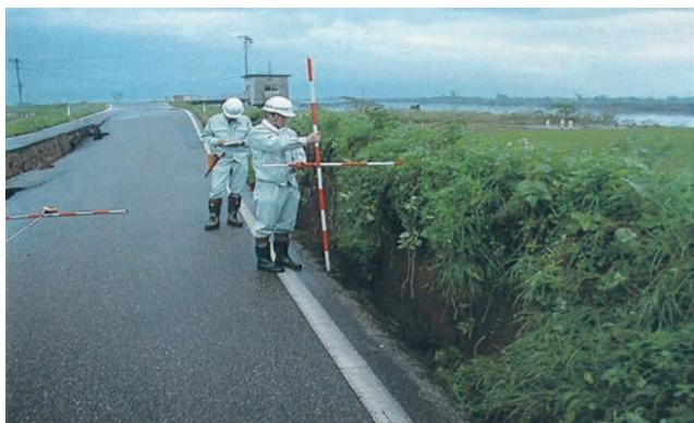
図-4.5 液状化により沈下した河川堤防
