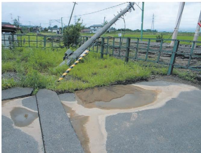
図-4.2 液状化により倒れた電柱と噴砂丘
