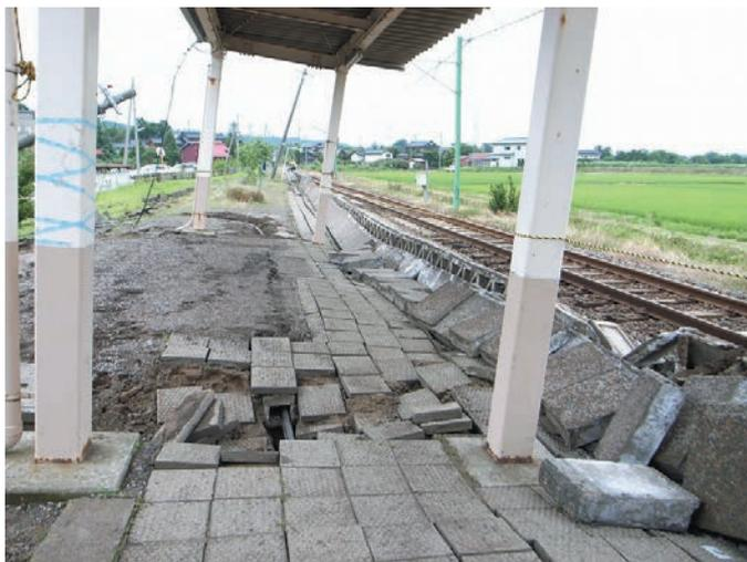
図-4.1 液状化による荒浜駅ホームの陥没
