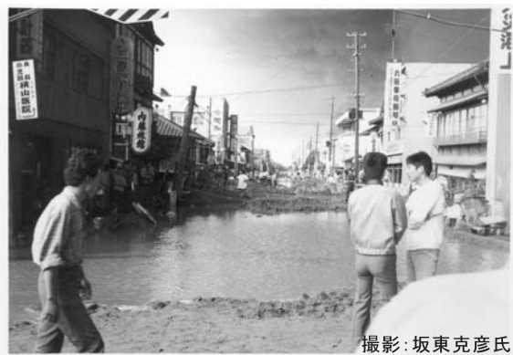
図一六 地震津波による浸水。新潟県の海岸には砂丘が発達しているため、津波は河川遡上型になります(新潟市中央区礎町)
