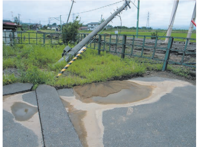
図-4.2 液状化により倒れた電柱と噴砂丘
