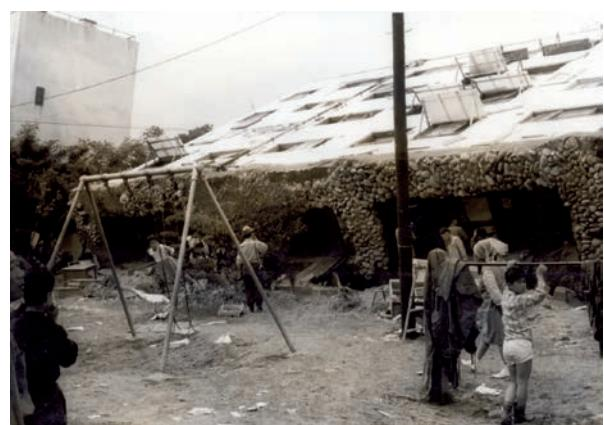
図-3.3 基礎部が現れた県営アパート(新潟市中央区川岸町)
