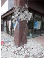
支持力のない柱
