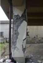
コンクリートが剥落し、鉄筋が露出した柱 | <input type="checkbox"/> ある | 危険 |
