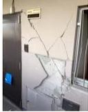
壁のX字ひび割れ                 | <input type="checkbox"/> ある | 危険 |
