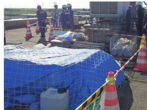
資機材が整理・整頓されていました
