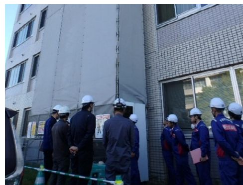
昇降用足場点検中
