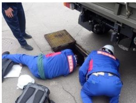
漏水箇所特定状況
