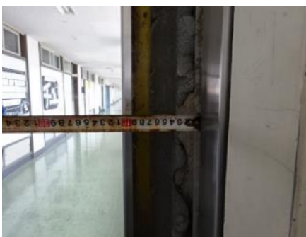
南校舎の移動（内部）
