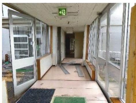
約30cm水平に移動した県有施設
