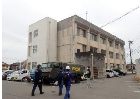
産業センター (調査後トイレが使用可能に)
