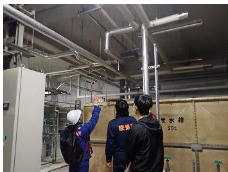
配管系統の確認状況
