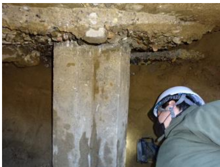
杭の調査状況
