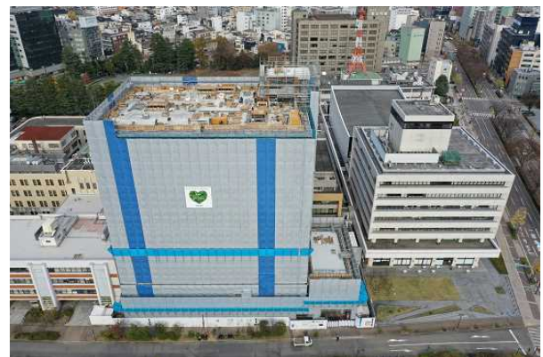
工事の進捗状況(R3.11末時点)
