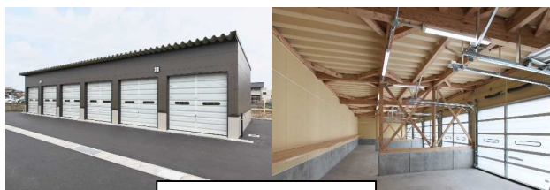
車庫の全景と内部
