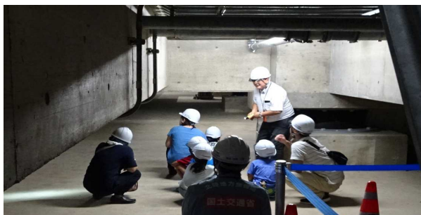
地下の免震装置の説明を聞く子供たち
