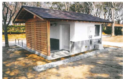
鳥屋野潟公園緑側帯トイレ外観
