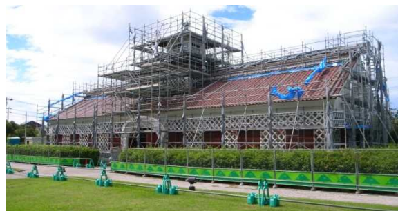
旧新潟税関庁舎 工事状況
