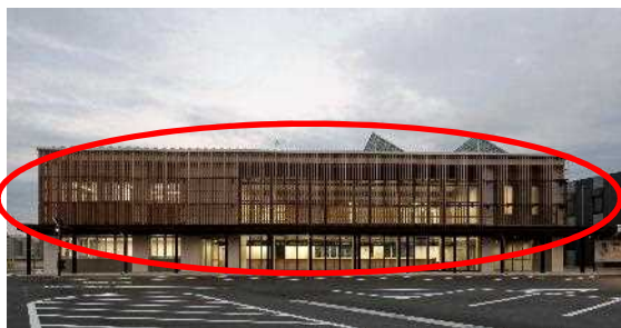
庁舎(外壁ルーバー)
