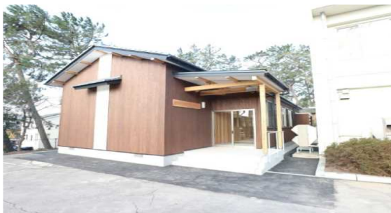
醸造試験場研修棟外観
