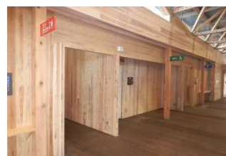
管理棟(CLTパネル工法)
