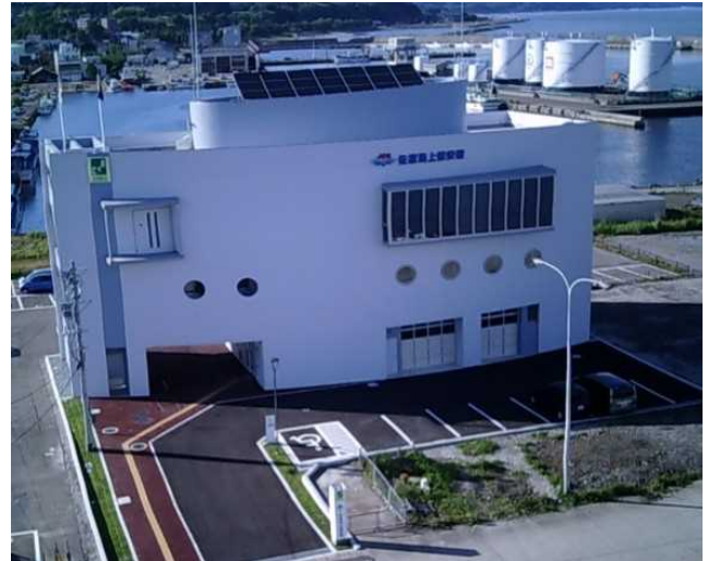
新築庁舎の外観（ドローンによる空撮写真）（photo by岡崎 淳）
