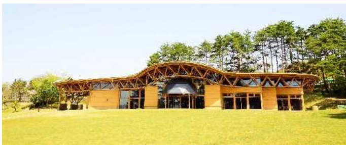
公園センター外観
