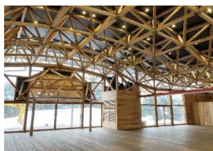
ホール棟(木造立体トラス工法)
