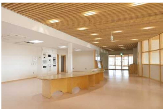
受付コーナーの天井ルーバー(県産の杉材使用)
