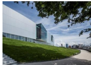
外壁(アルミ特注パネル使用)
