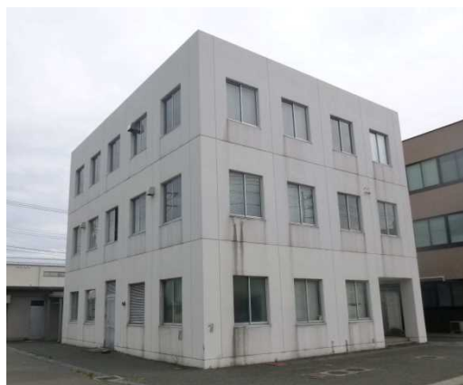
北陸農政局新潟支局庁舎 (既設)
