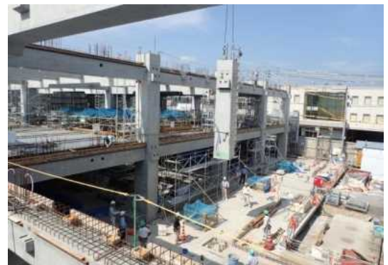
PCa・PC部材架設状況(第1工区)
