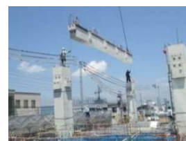
PCa梁建込み
