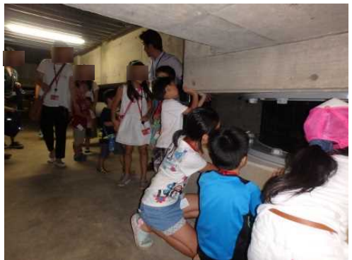
地下免震ピットで現物を説明
