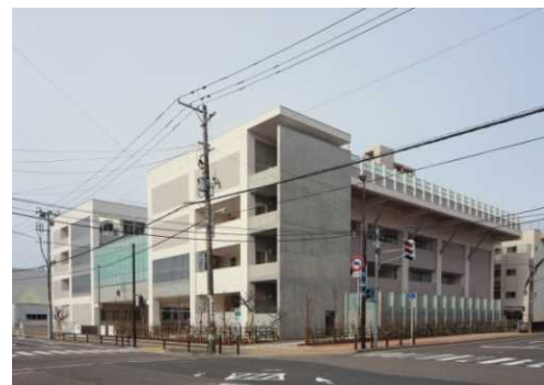
屋上避難用屋外階段
