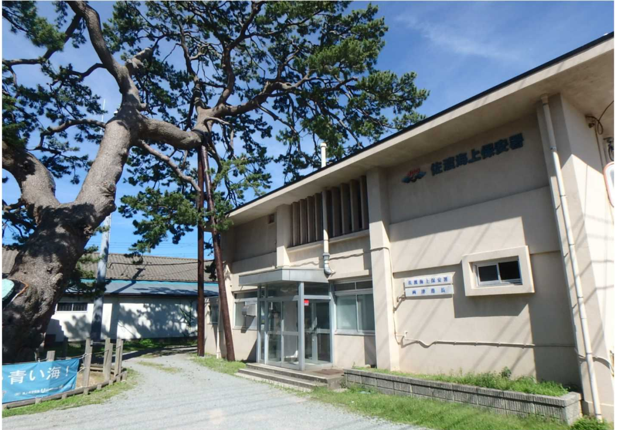
「今年度、移転整備工事に着手する 佐渡海上保安署 既存庁舎」
